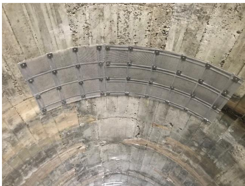
写真3-2 措置の事例（長池トンネル：剥落防止ネット工）
