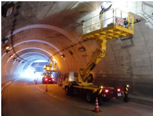
写真3-1 近接目視による点検状況
