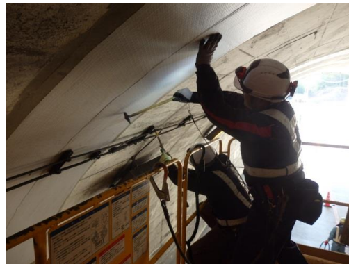
写真3-1 近接目視による点検状況
