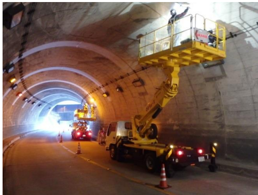
写真3-1 近接目視による点検状況
