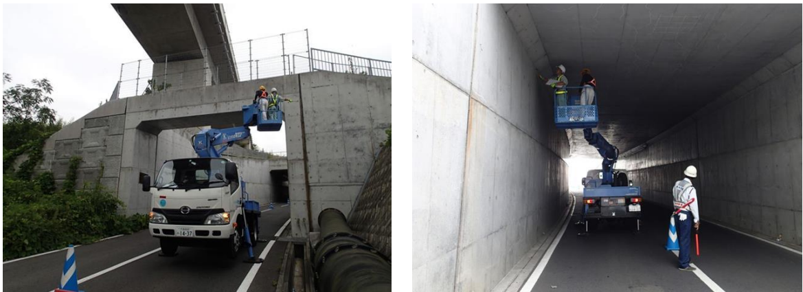
写真3-1 近接目視による点検状況
