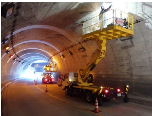
写真3-1 近接目視による点検状況
