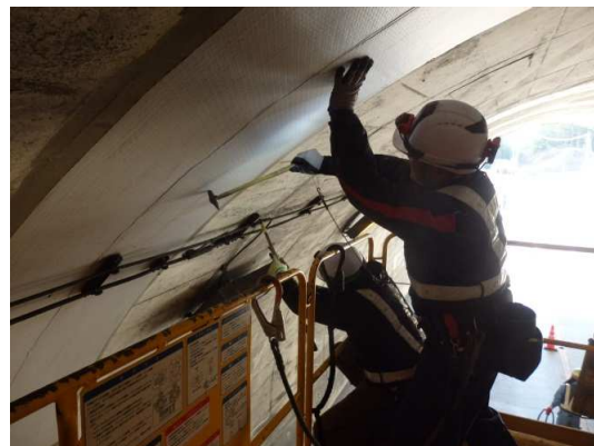
写真3-1 近接目視による点検状況
