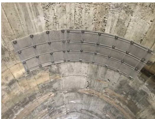
写真3-2 措置の事例(長池トンネル:剥落防止ネット工)
