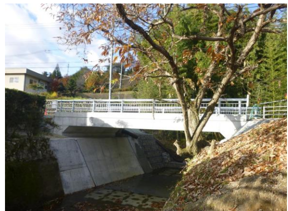
写真4-3 措置（橋谷橋：架け替え）
