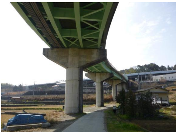
写真4-2 措置（南海跨線橋：塗替え）
