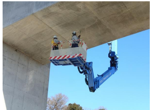
写真4-1 近接目視による点検状況
