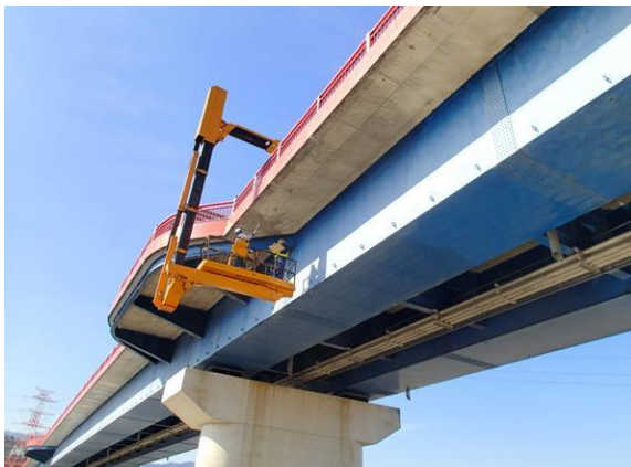
写真4-1 近接目視による点検状況
