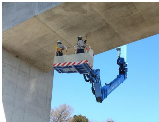
写真4-1 近接目視による点検状況
