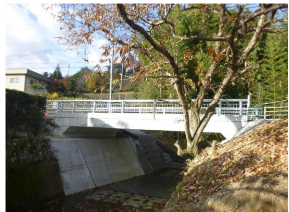
写真4-3 措置（橋谷橋：架け替え）
