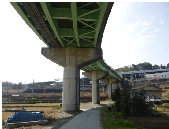
写真4-2 措置（南海跨線橋：塗替え）
