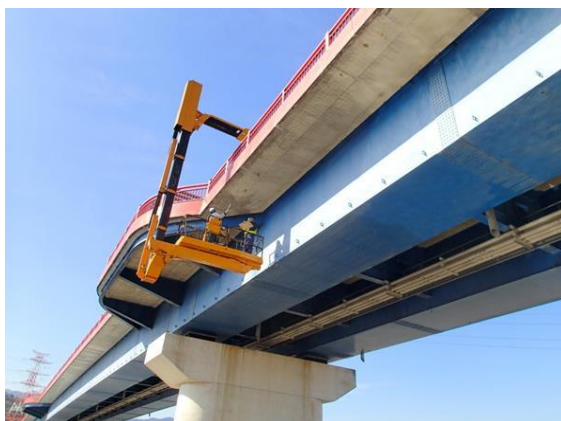
写真4-1 近接目視による点検状況
