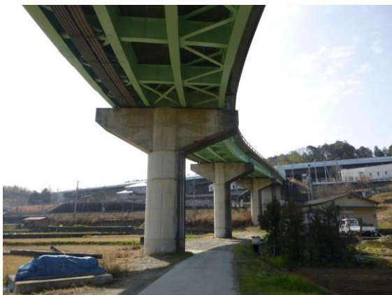
写真4-2 措置（南海跨線橋：塗替え）
