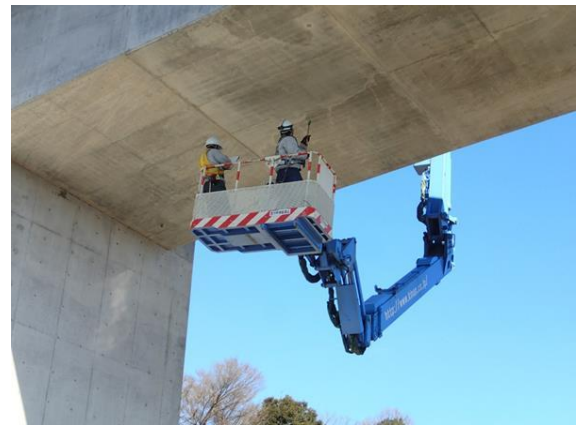
写真4-1 近接目視による点検状況
