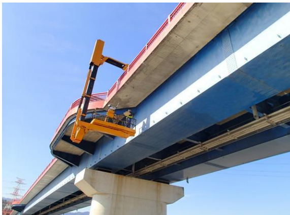
写真4-1 近接目視による点検状況
