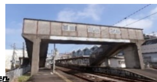
既存施設の 撤去
