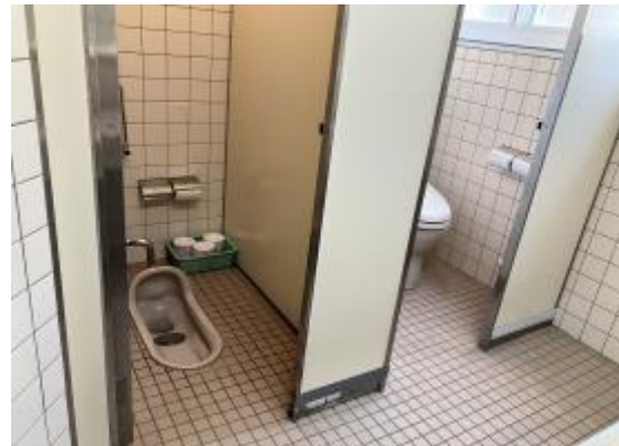
古いトイレのようす
