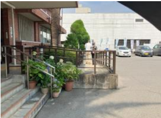
屋根のないスロープ
