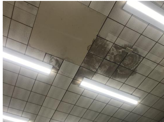
天井の雨漏りの様子
