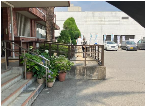
屋根のないスロープ
