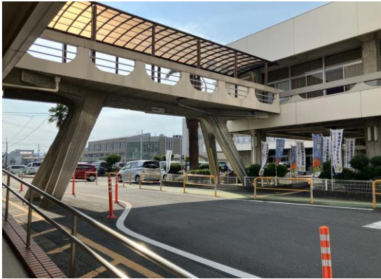
2 階の連絡通路
