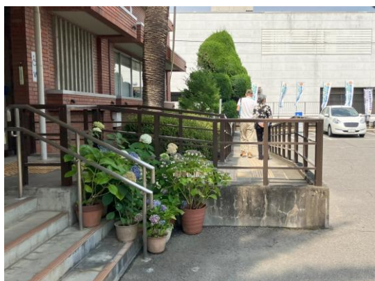
屋根のないスロープ
