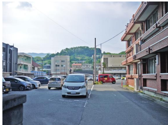
分かりづらい車路動線と駐車マス
