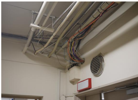
天井や壁のむき出しの配管・配線
