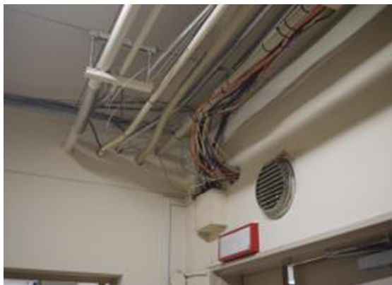
天井や壁のむき出しの配管・配線
