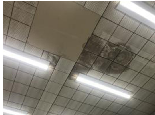
天井の雨漏りの様子
