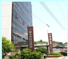
⑤橋本地区公民館
