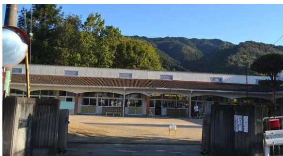
▲解体予定の柱本幼稚園
