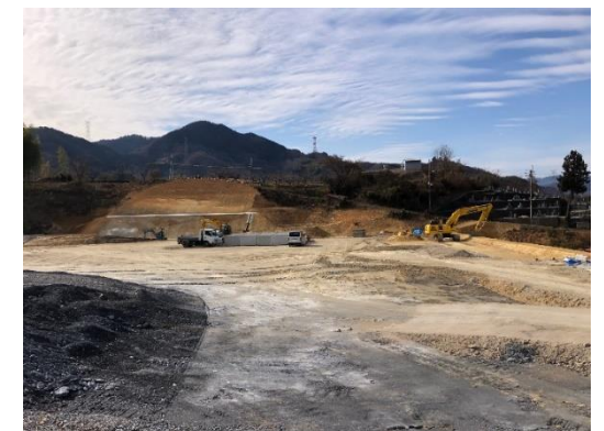
▲工事現場の様子
