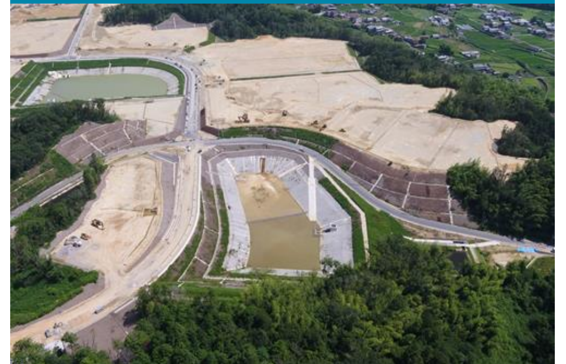
④ 調整池付近の施工状況
