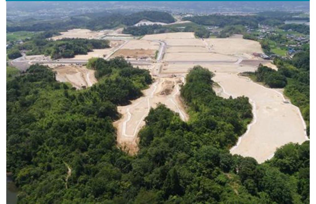
③ 事業区域全景(北側から)
