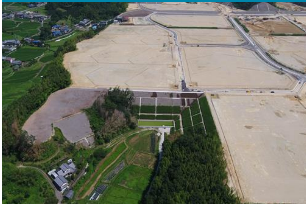
② 分譲宅地の施工状況
