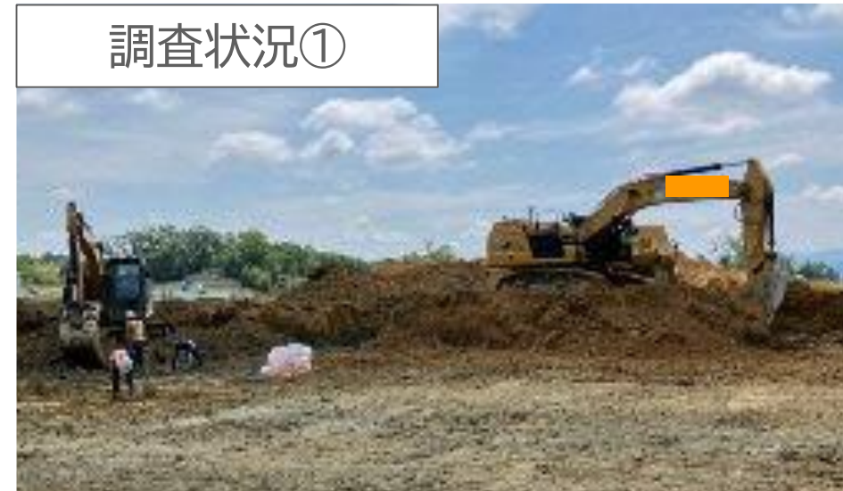
【調査状況①】
