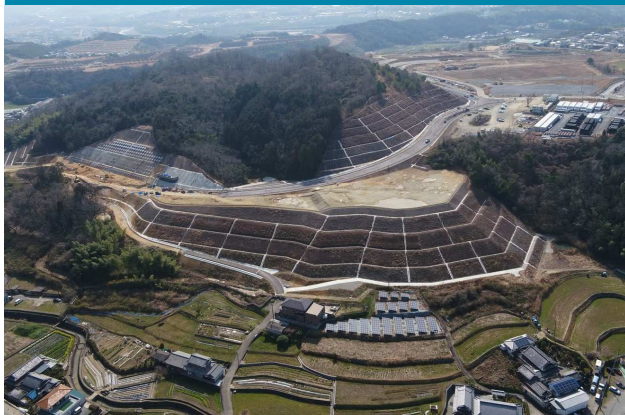
② 山内南公園付近を撮影
