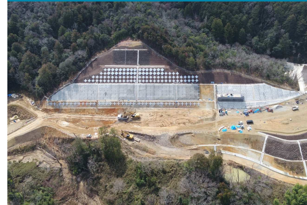
③ 法面对策工事の施工状況
