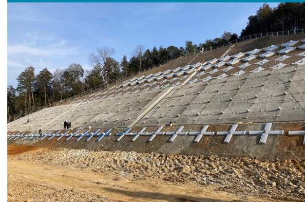
④ 法面对策工事の施工状況
