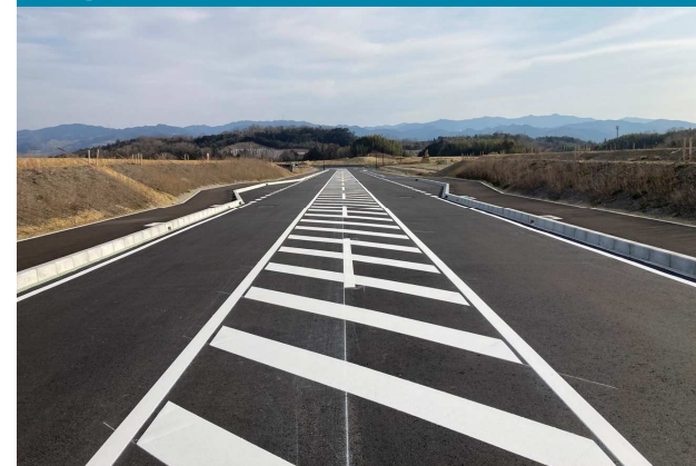
⑦ 都市計画道路の施工状況
