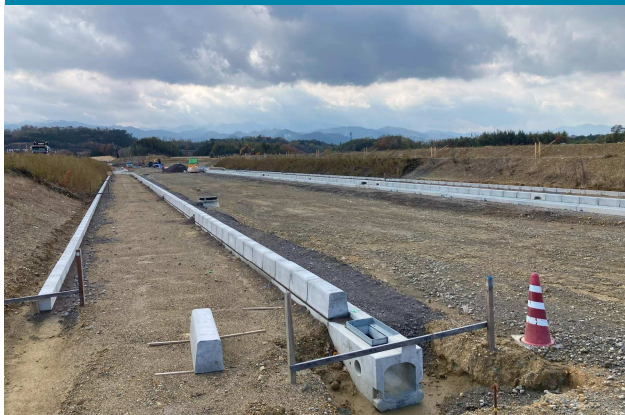
⑥ 都市計画道路の施工状況
