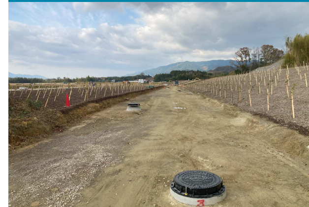
⑦ 区画道路の施工状況
