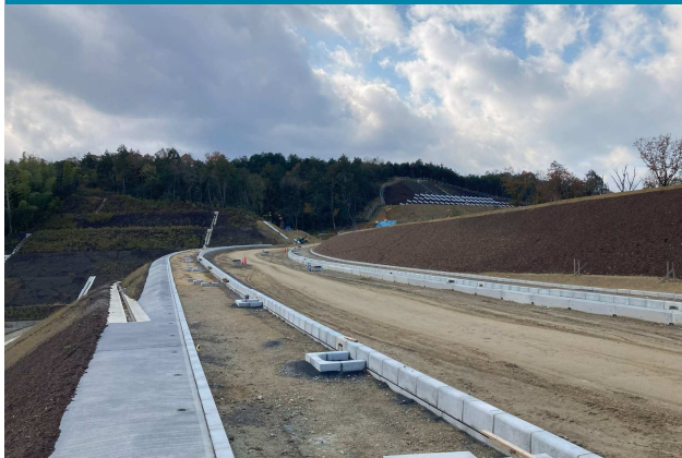
⑤ 都市計画道路の施工状況
