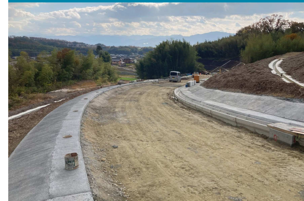
⑧ 平野接続道路の施工状況
