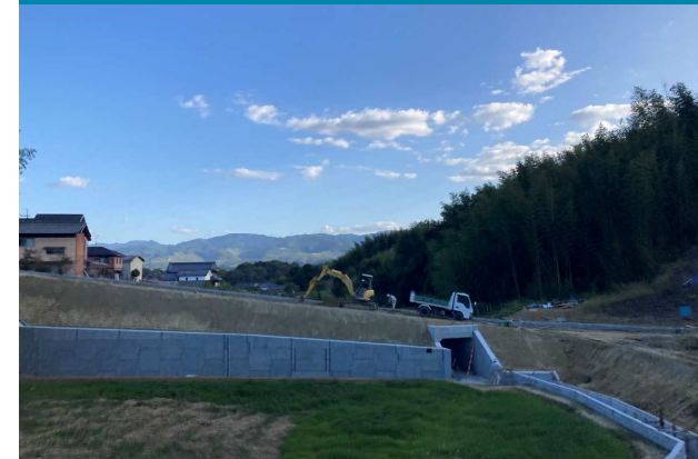
⑧ 平野接続道路の施工状況
