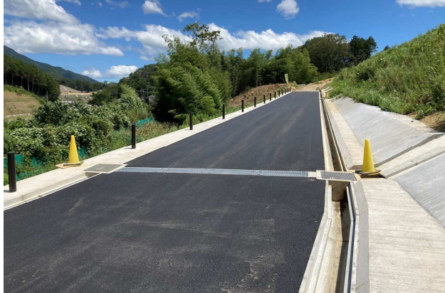
⑤ 山内南接続道路の施工状況
