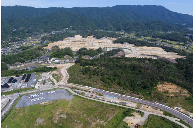
① 現場事務所から北側を撮影
