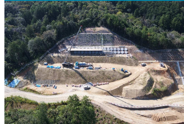
③ 法面对策工事の施工状況
