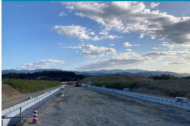
⑥ 都市計画道路の施工状況
