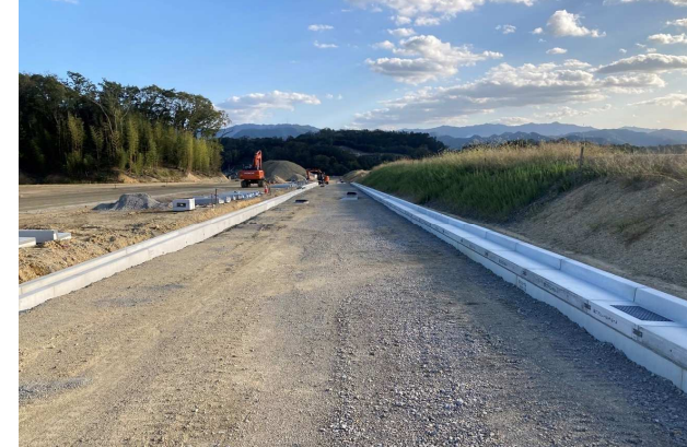
⑦ 区画道路の施工状況
