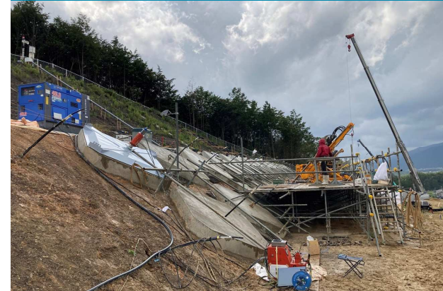
④ 法面对策工事の施工状況
