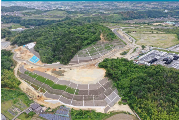
② 山内南公園付近を撮影
