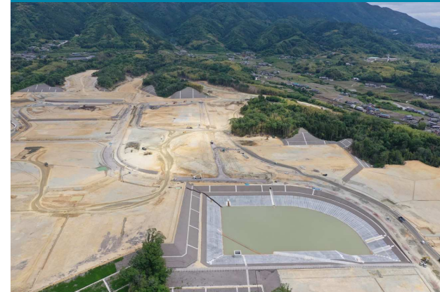
③ 県道北側の施工状況
