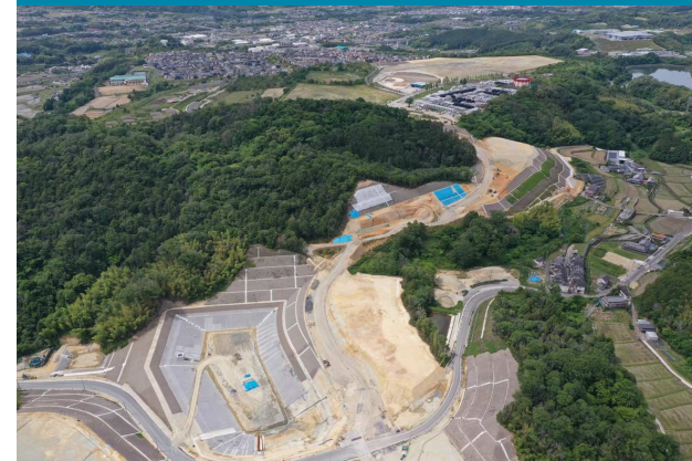
④ 県道南側の施工状況
