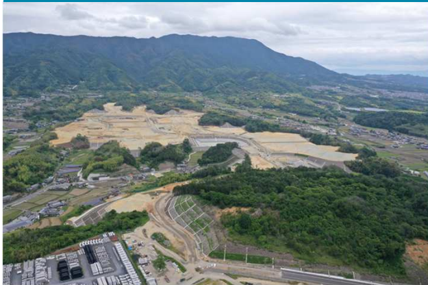
① 現場事務所から北側を撮影
