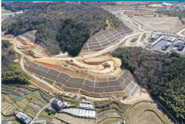
② 山内南公園付近を撮影
