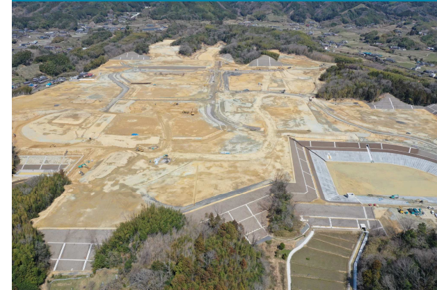
③ 県道北側の施工状況
