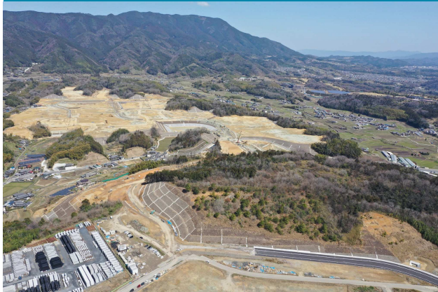
① 現場事務所から北側を撮影
