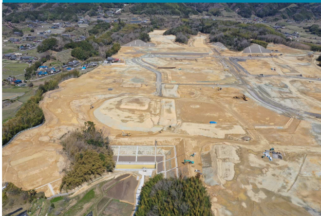
⑤ 大谷池付近の施工状況
