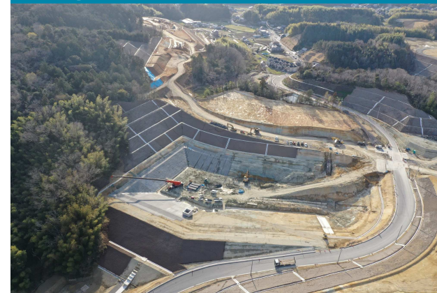
⑦ 2号調整池の施工状況
