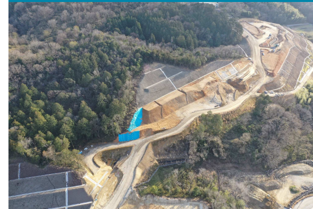
④ 県道南側の施工状況
