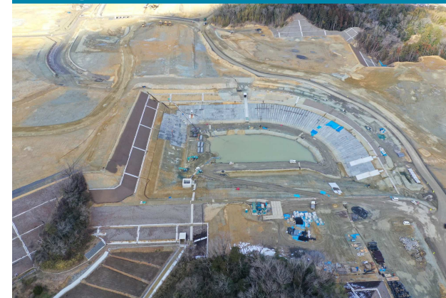
⑦ 1号調整池の施工状況
