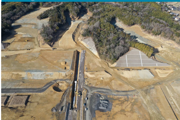
⑥ 雨水函渠の施工状況
