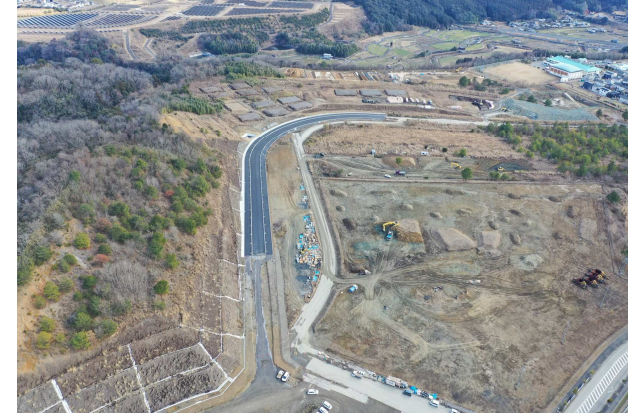
③ 山内垂井線の施工状況
