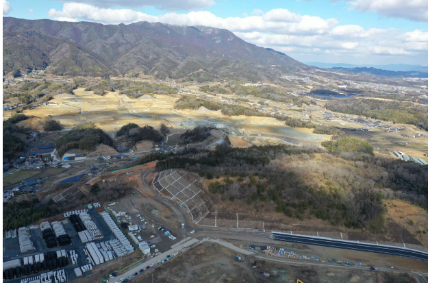
① 現場事務所から北側を撮影
