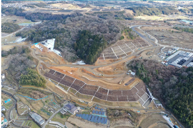
② 山内南公園付近を撮影
