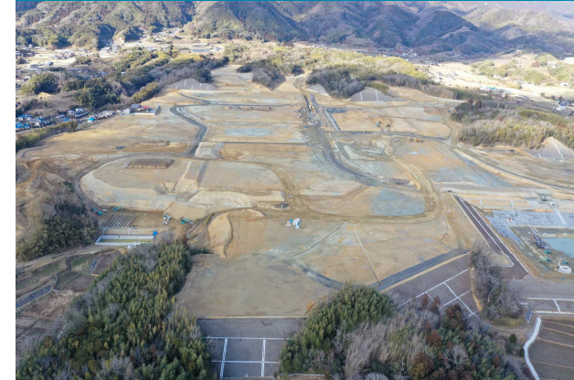
④ 県道北側の施工状況
