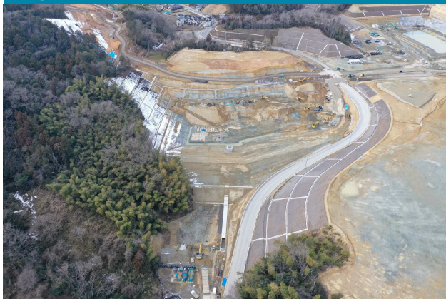
⑤ 2号調整池付近の施工状況
