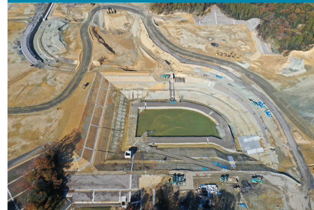
⑦ 1号調整池の施工状況
