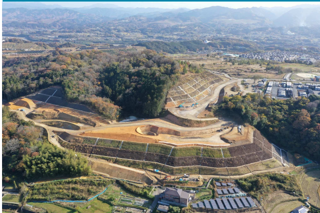
② 山内南公園付近を撮影
