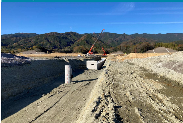
⑥ 雨水函渠の施工状況
