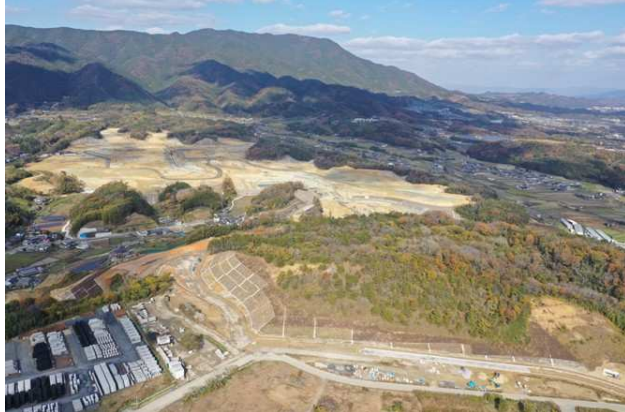
① 現場事務所から北側を撮影
