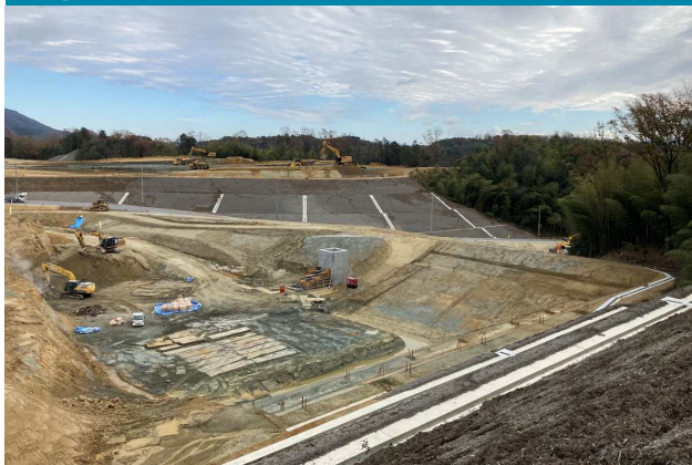
⑤ 2号調整池付近の施工状況
