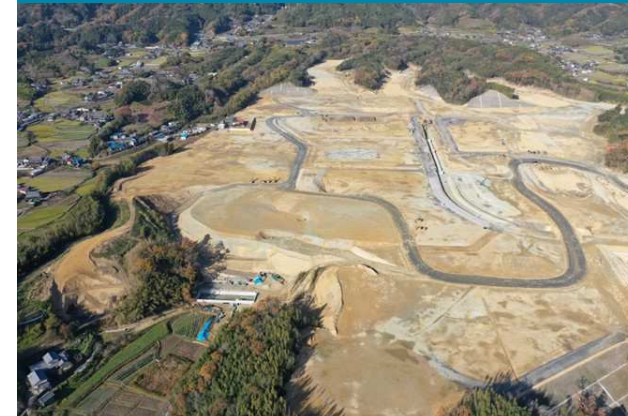
④ 大谷池 北側の施工状況
