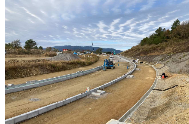
③ 山内垂井線の施工状況
