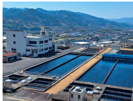
▲浄水場（隅田町真土）
