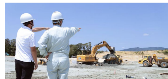
◀造成工事の様子
