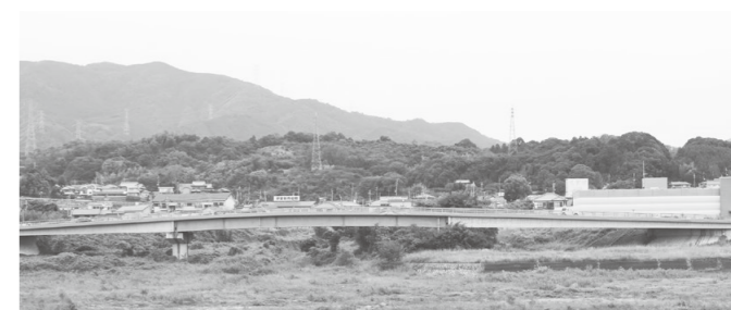
▲補修工事を行なった山田川橋
