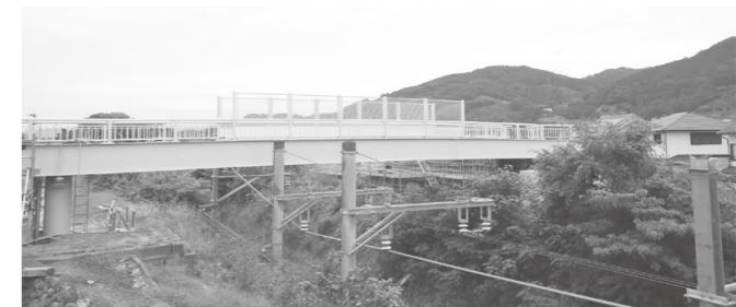
▲新橋を製作した河瀬陸橋（現在、接続道路を建設中）
