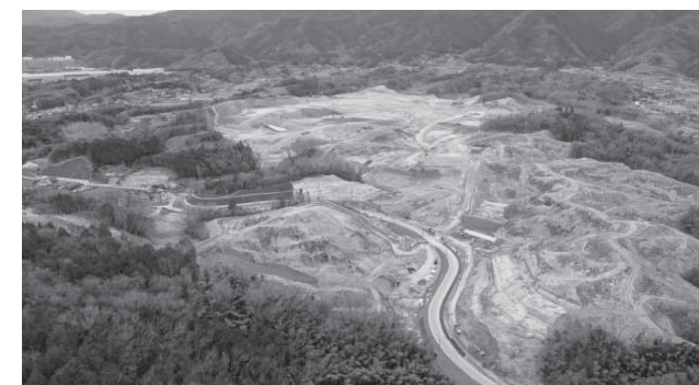
▲造成工事の様子
