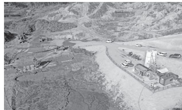
▲造成工事の様子
