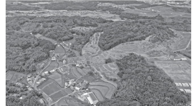
▲造成工事の様子（令和2年9月末時点）
