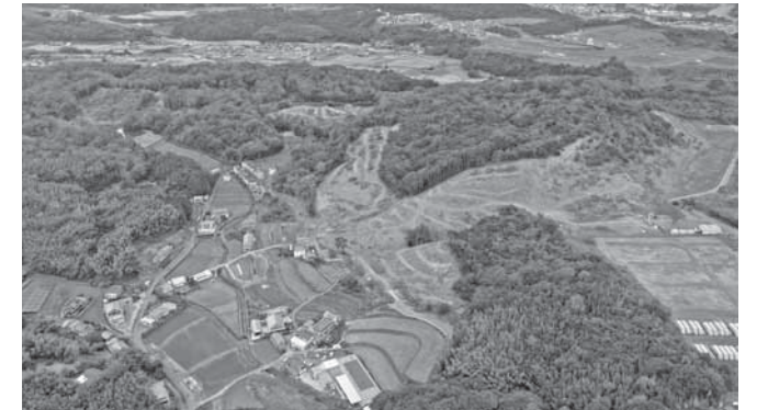
▲造成工事の様子（令和2年9月末時点）
