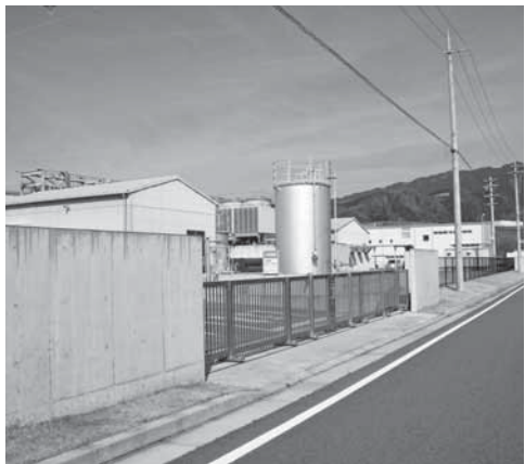
▲工場などの建設が進む企業誘致団地
