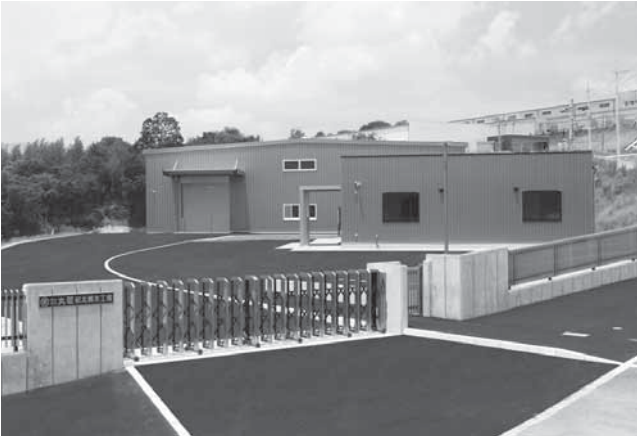
▲紀ノ光台Sゾーン用地で操業する「紀北橋本工場」
