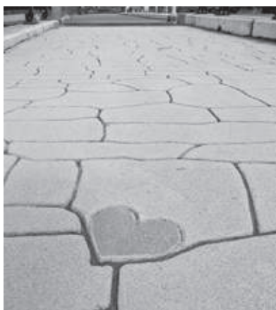
▲恋野橋の歩道
