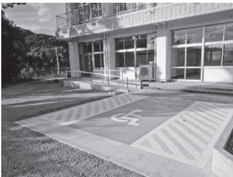
▲柱本小学校の空き教室を改修工事中
