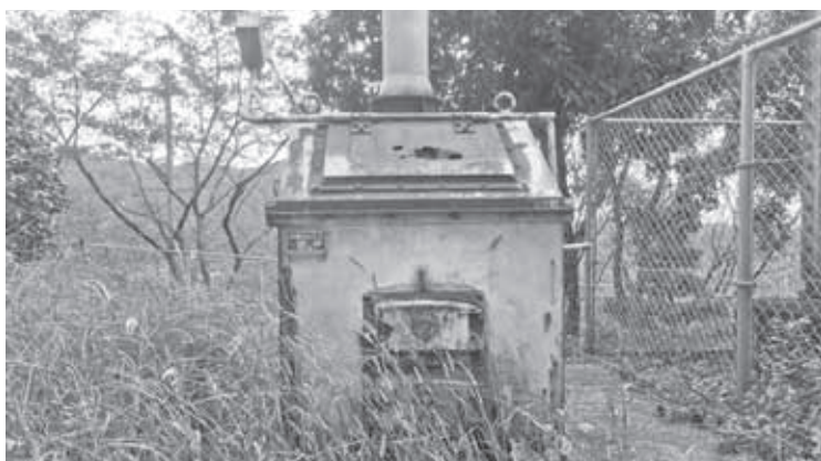
いまだ撤去されていない焼却炉
