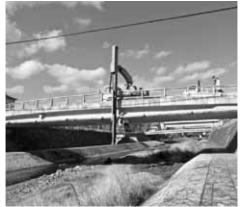
施設(橋梁)点検の様子
