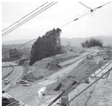
建設中の371号バイパス（三石台）
