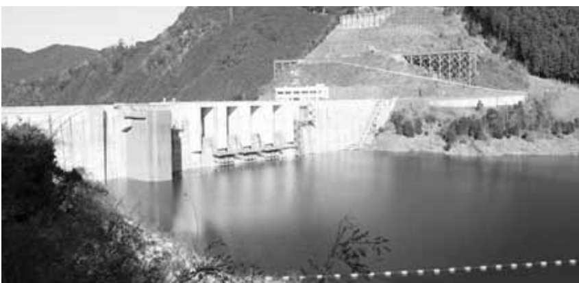
洪水調節と利水を目的とした大滝ダム(1月12日撮影)
