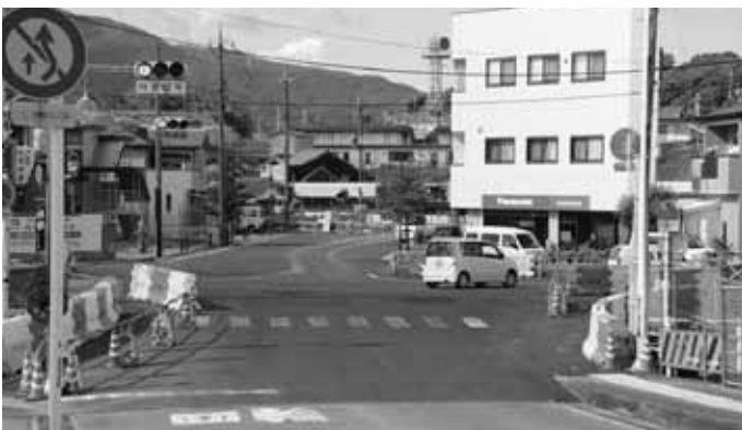
橋本橋北詰の国道24号交差点付近。写真奥が一部完成した都市計画道路古佐田橋本線
