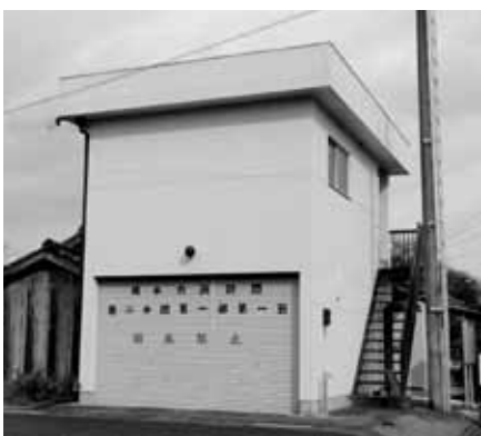
トイレ改修工事が終了した第二分団(岸上地区)消防団器具庫
