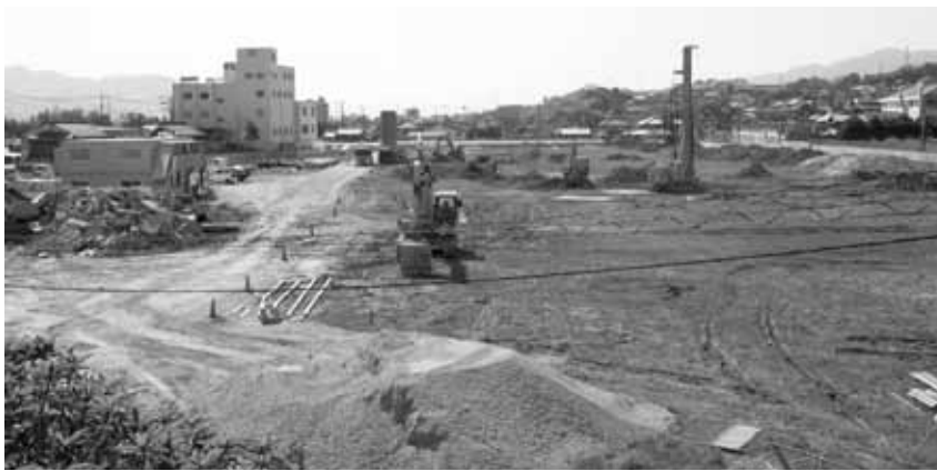
(仮称) スーパーセンターオークワ橋本店建設 予定地
