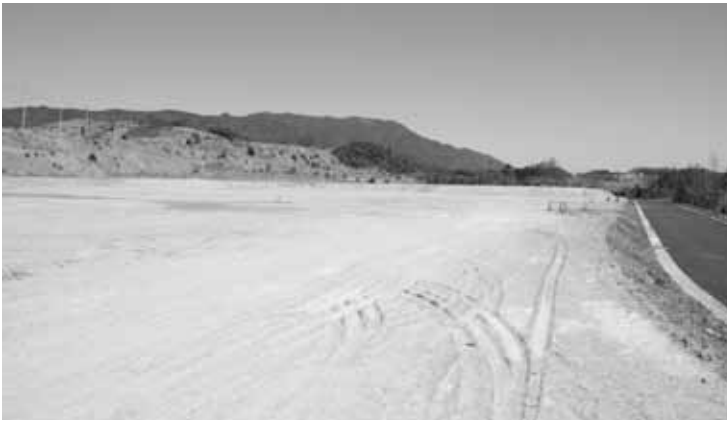
平成25年4月開校予定のあやの台小学校の建設予定地
