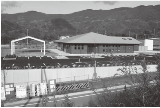
▲ 広域ごみ焼却場の周辺整備事業として、建設されている橋本市エコパーク「紀望の里」
