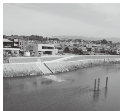
▲土地の区画整理事業に伴う、紀の川護岸工事
