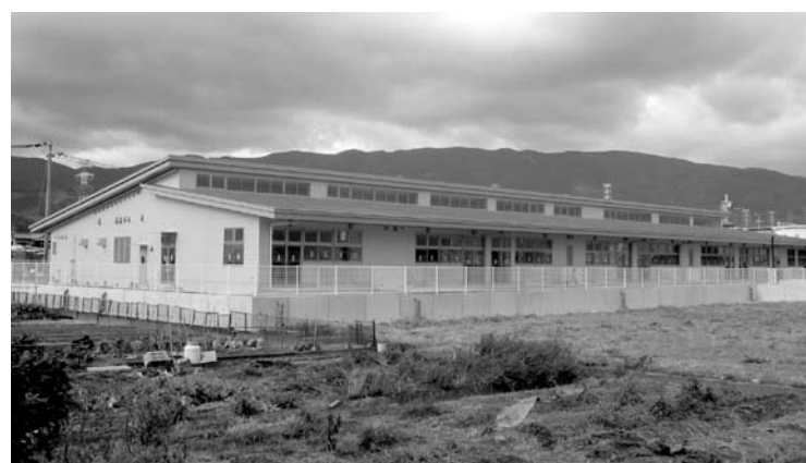
完成に向け建設工事が進む高野口こども園（向島）
