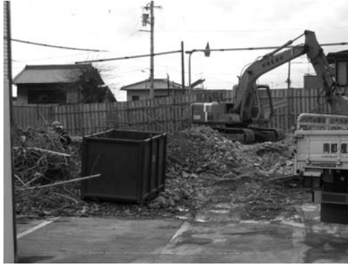
高野口地域交流センター建設のため解体中の旧高野口庁舎北別館
