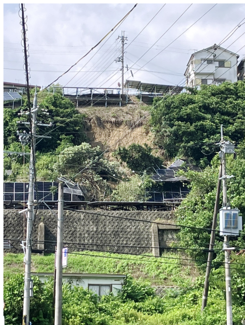
▲土砂崩れがおきた斜面（高野口町応其）
