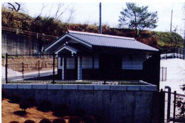
西川浄化センター
