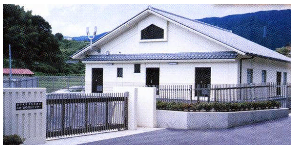
山田・出塔浄化センター
