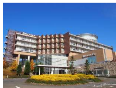
橋本市民病院（災害拠点病院）
