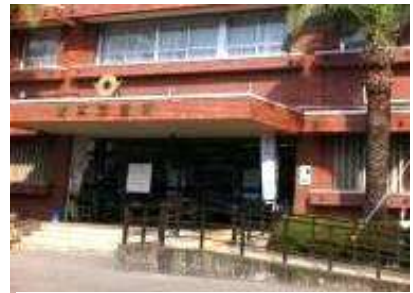
市役所玄関のスロープ
