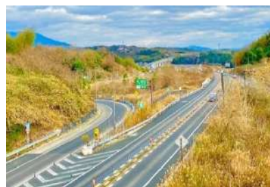
京奈和自動車道（橋本道路）
