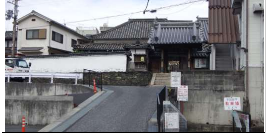
応其寺周辺段差の状況
