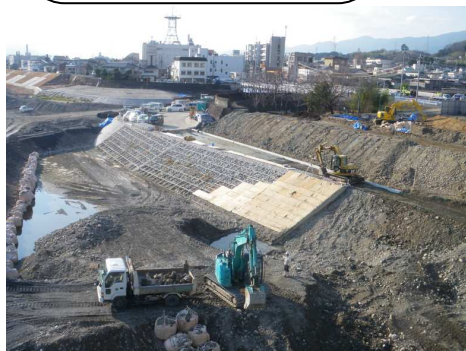
↑ (写真右から) Cブロック、Dブロック、下流部の護岸整備工事の様子
