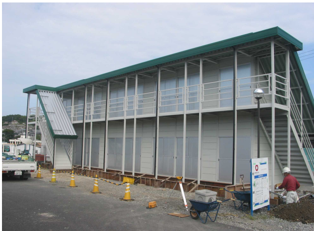
建築中の第3仮倉庫
